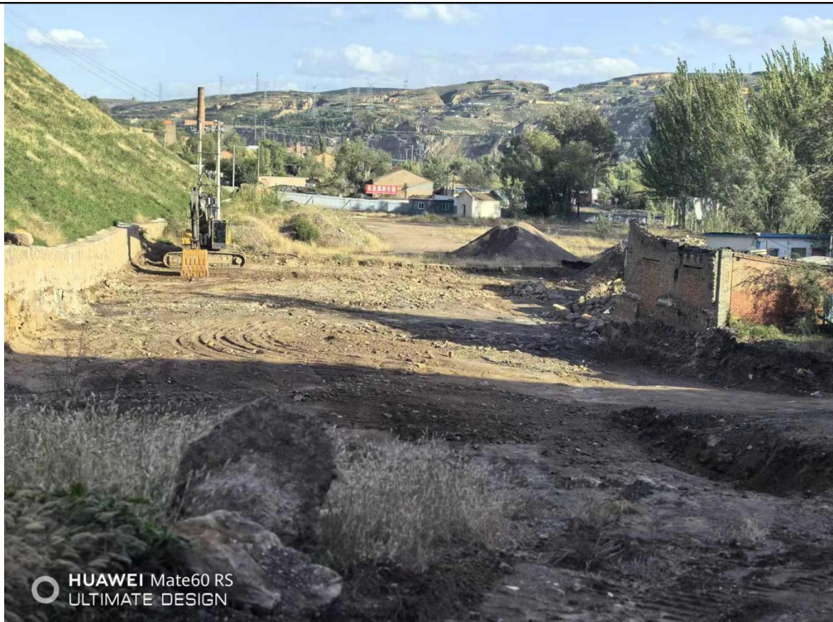
图 2.11.-1 拟建仓储车间 2 场地现状
