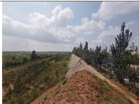
降压站进线处
