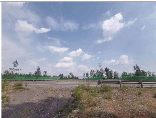
跨越 G338 国道
