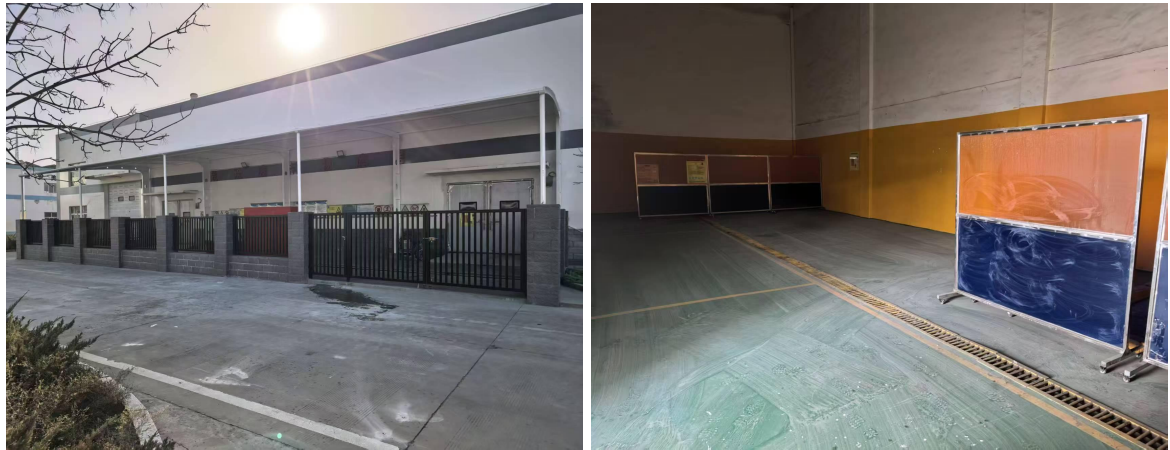
图 2-8 危废库现状照片
