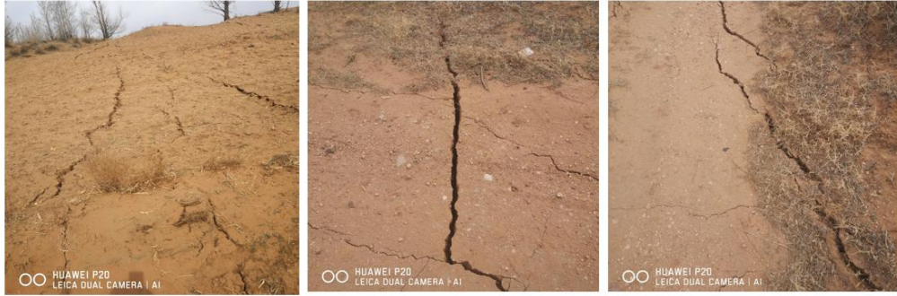
图 2-8 局部范围地裂缝照片图
