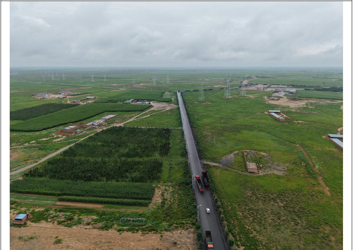
110kV 风电送出线路沿线现状
