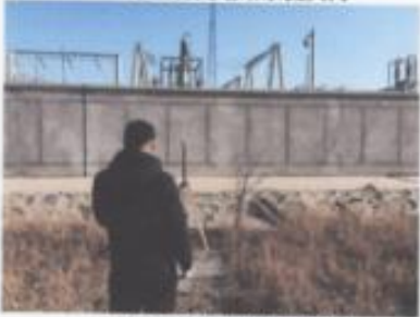
110kV 章盖营变电站西侧
