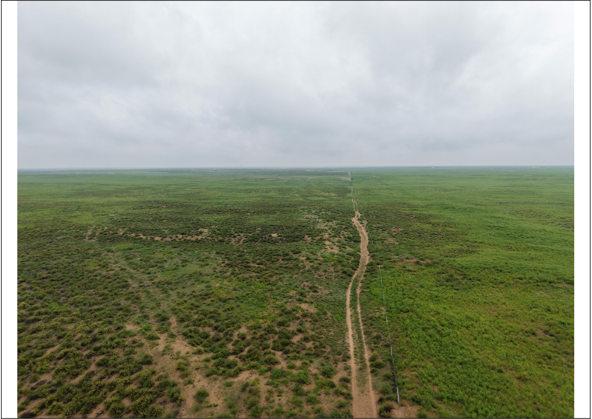
110kV 风电送出线路沿线现状
