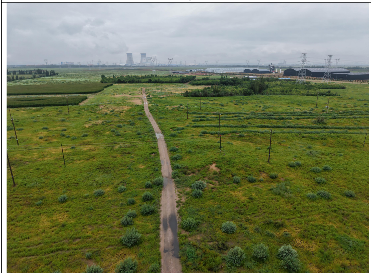
110kV 光伏送出线路沿线现状
