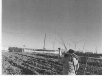
110kV 台裕线 36#-37#塔
