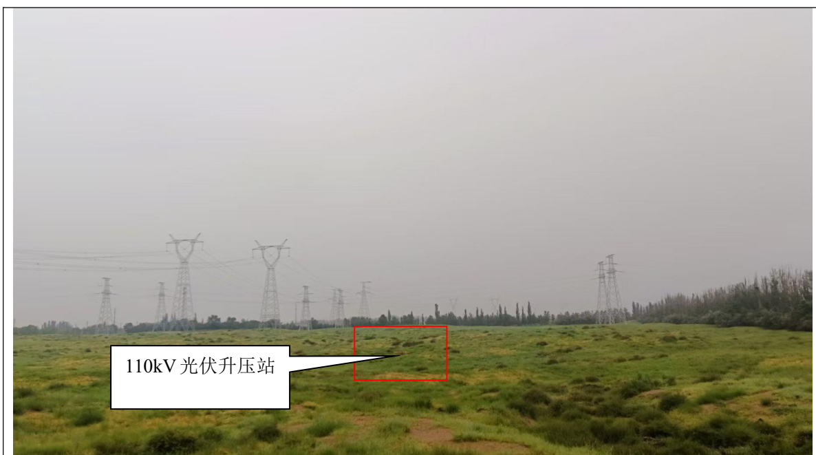
110kV 光伏升压站
