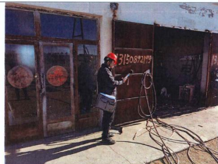
变电站东侧168m专业电气焊补胎检测
