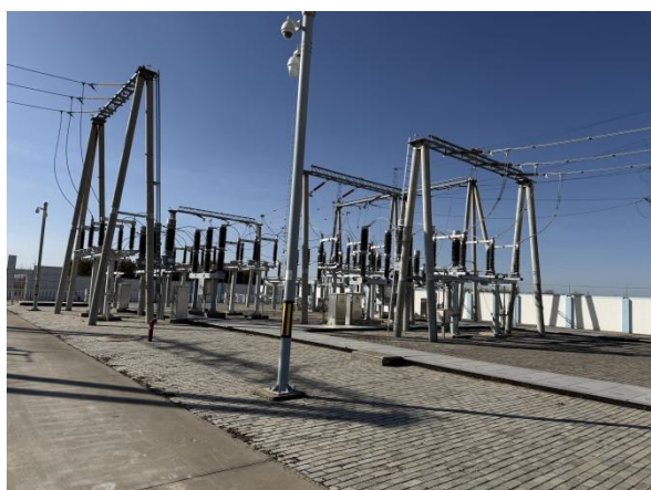
查汗苏立德 110kV 变电站站内硬化
