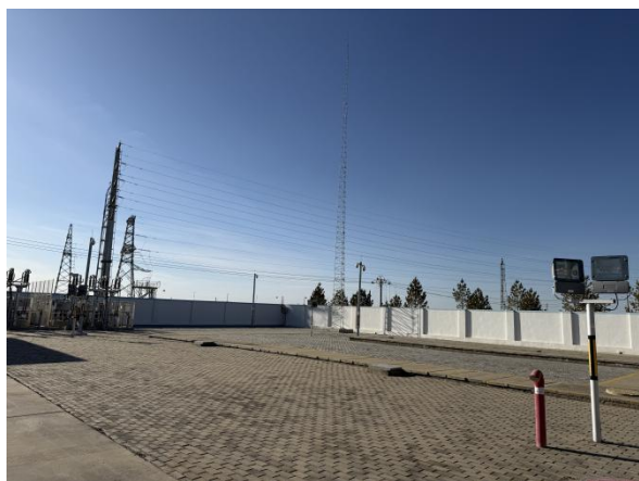
陶利 110kV 变电站内硬化
