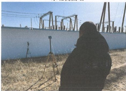
西北侧围墙 (扩建间隔处)
