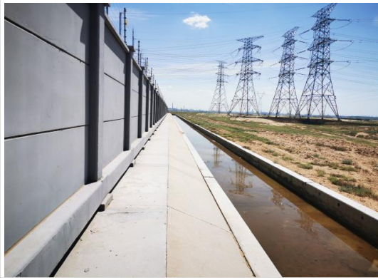
迭哨畔变电站西侧围墙处
