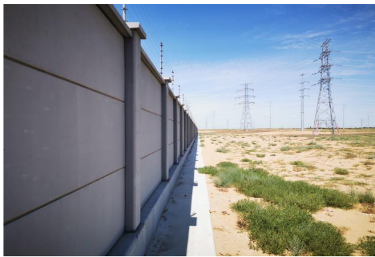
迭哨畔变电站东侧围墙处
