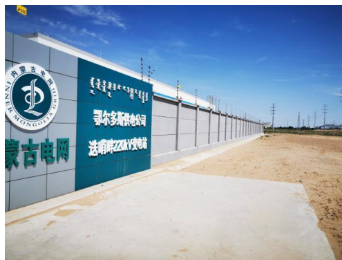
迭哨畔变电站南侧围墙处
