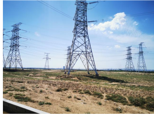
迭哨畔变电站西侧围墙外
