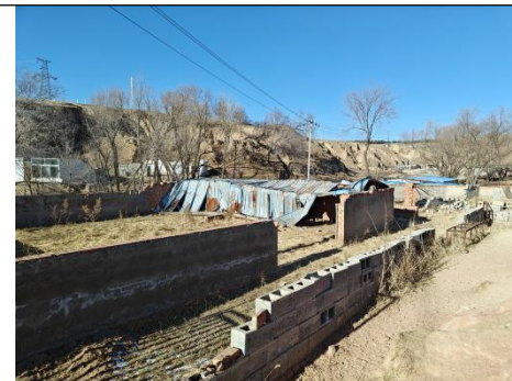
土盖沟村民房 1
