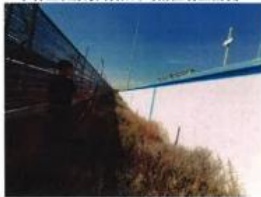
民安 220kV 变电站南侧围墙
