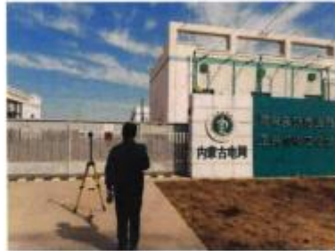
王贵 110kV 变电站南侧大门
