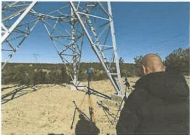
110kV 宫装线 37#塔下
