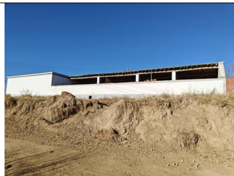
土盖沟村民房 3
