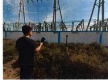
民安 220kV 变电站西侧围墙
