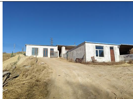
土盖沟村民房 3
