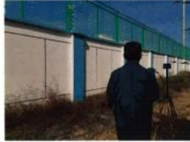
王贵 110kV 变电站东侧围墙
