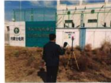
110kV 民贵 I 线进线处
