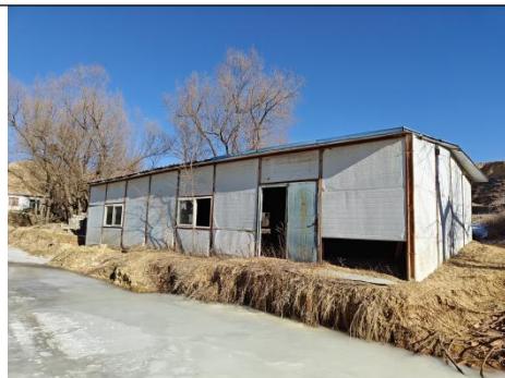
土盖沟村民房 5
