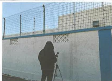
罕台 110kV 变电站北侧
