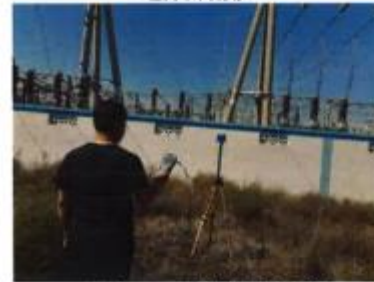
民安 220kV 变电站东侧围墙
