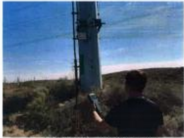
110kV 民贵 I、II 线 001#塔下
