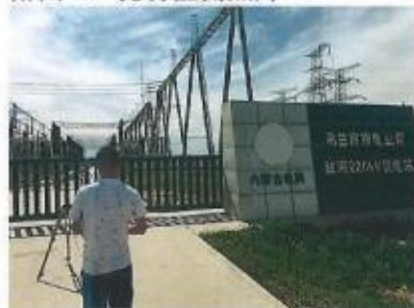
盐海 220kV 变东
