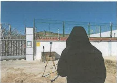
装备 220kV 变电站东侧
