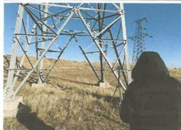
110kV 莲罕线 61#塔下
