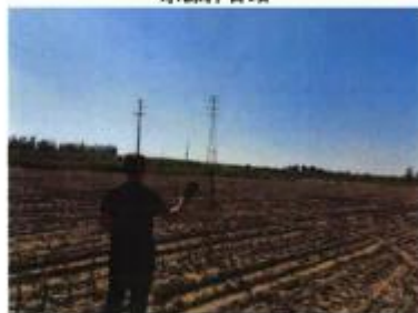
110kV 民贵 I、II 线 衰减处
