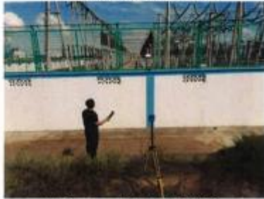
民安 220kV 变电站南侧围墙
