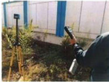
王贵 110kV 变电站北侧围墙
