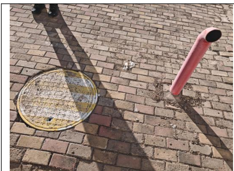
罕台变事故油池
