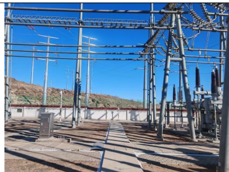
装备 220kV 变间隔扩建处
