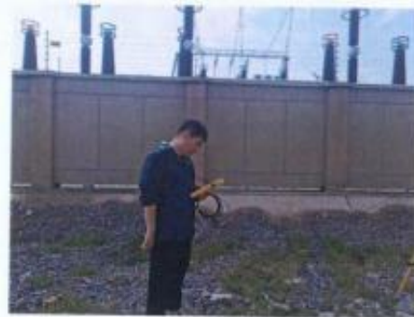
东风变电站南侧围墙外电磁检测
