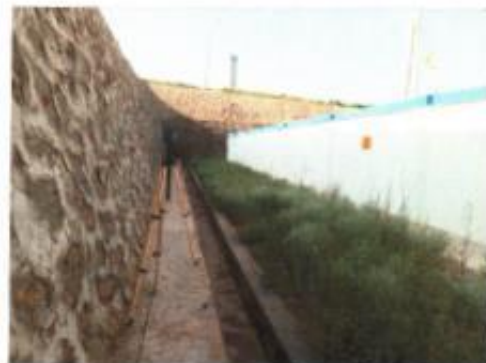
白界 110kV 变电站西厂界
