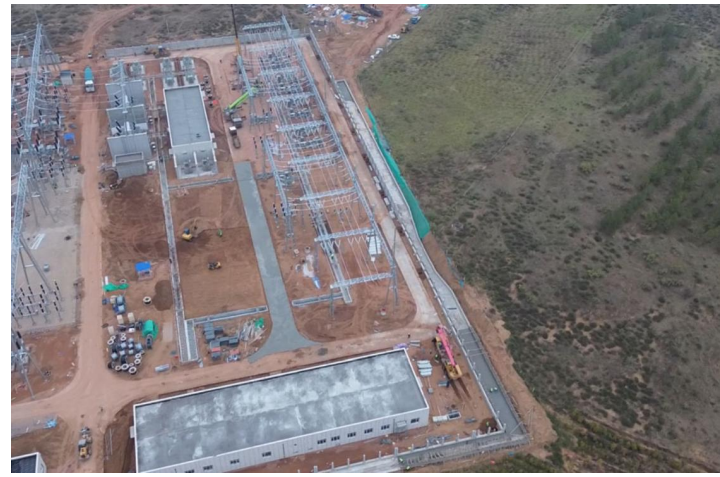
变电站南侧围墙外
