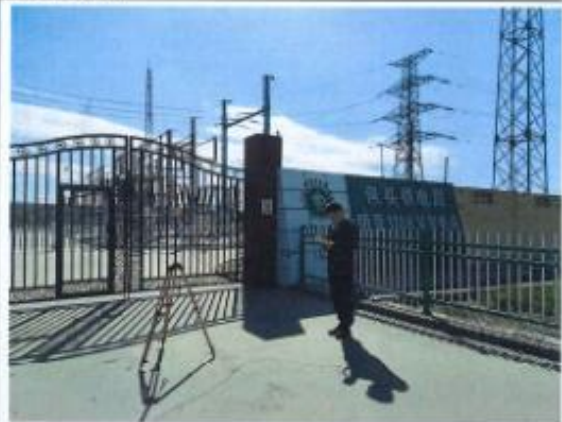
明登变电站大门口电磁检测
