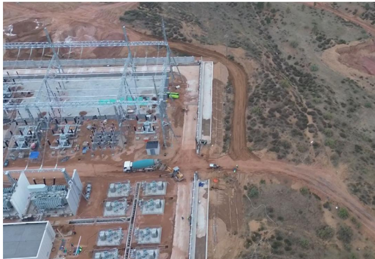
变电站东侧围墙外
