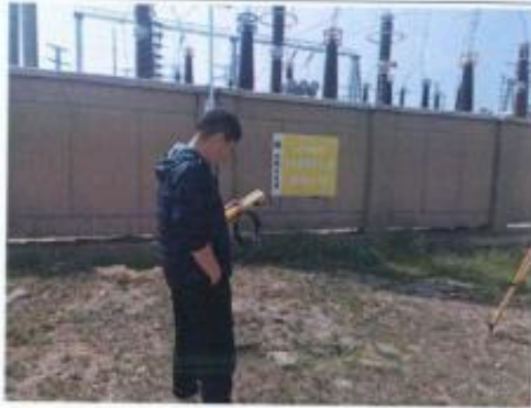
东风变电站北围墙外电磁检测
