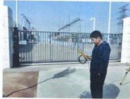
东风变电站大门口电磁检测
