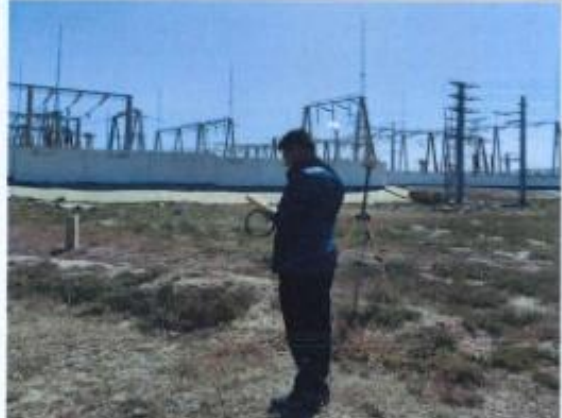
电缆电磁断面检测
