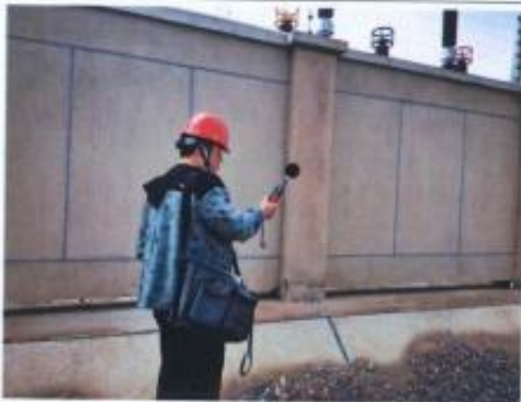
东风变电站南侧围墙外噪声检测
