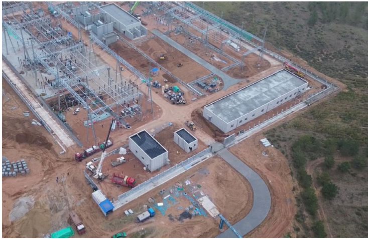
变电站西侧围墙外
