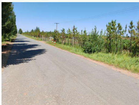
跨越阿苏线三级公路处
