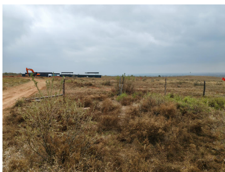
尔胡梁 110kV 变电站施工中
