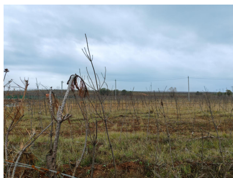
苏布尔嘎煤矿 110kV 变电站进线处
