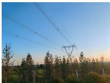
钻越 220kV 电力线
