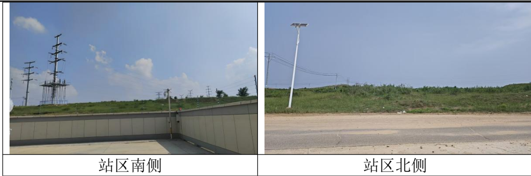
图 2-1 建设地点现场情况
